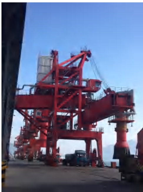
装船机及伸缩溜管
