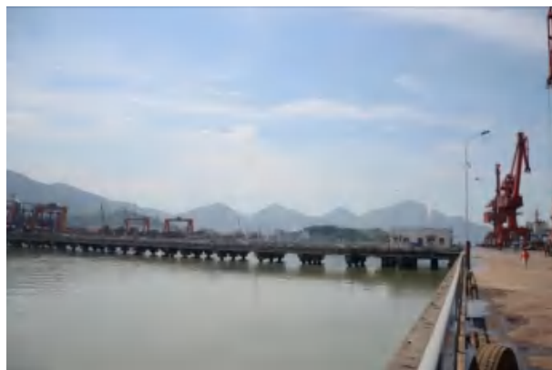
6#、7#泊位码头栈桥
